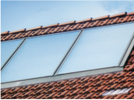
Thermische Sonnenkollektoranlage
