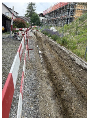
Einbau Regenabwasserleitung Lettenstrasse
