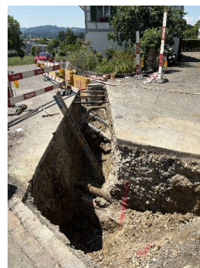
Einbau Wasserleitung Steinacker-/Freudenbergstrasse
