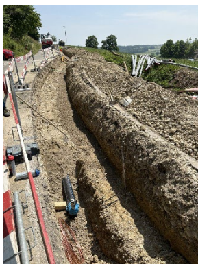
Einbau Wasserleitung Wüesti
