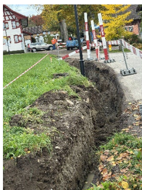
Bau Hausanschluss Chöll
